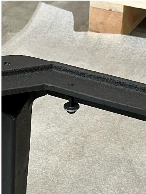
6. Drehen Sie die Positions-sicherungsschrauben am Sockelrahmen so weit heraus, dass diese nicht nach oben überstehen.
