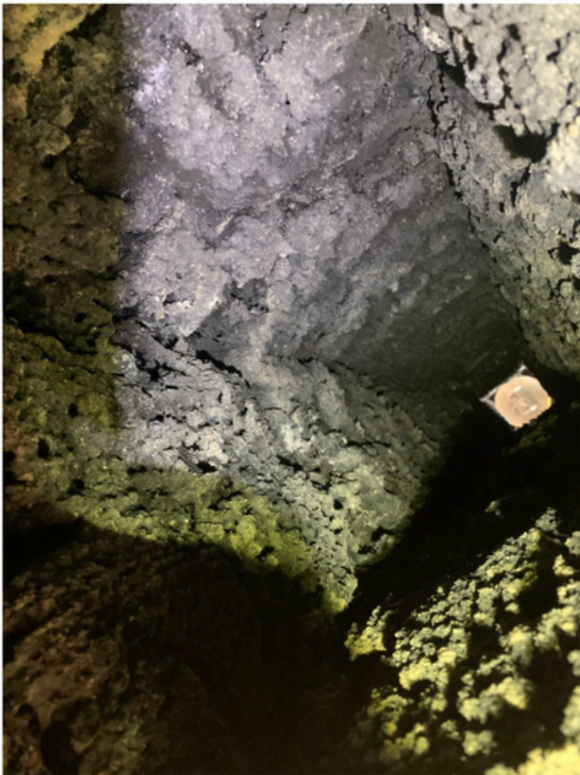
Bildet fra pipeløpet viser at pulveret som er automatisk utløst av varmen har lagt seg som en hinne innvendig i pipa. Foto: Eivind Ruud-Nilsen, KBR
