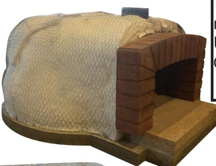
**NR 4** Legg på keramisk isolasjon , 1 rull keramisk isolasjon holder til Forno vero kit 85 .
