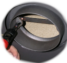
Fig. 16 Sørg for, at røgtuden sidder centreret og spænd herefter boltene
