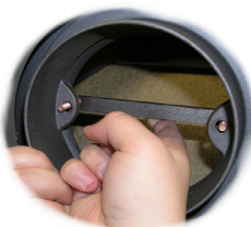
Fig. 15 Spænd røgtuden fast bag på ovnen med holderen eller bolte.
