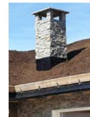
Ferdig forblendet pipe med hvelplate i skifer.
