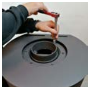
Innvendig dekkning fjernes
