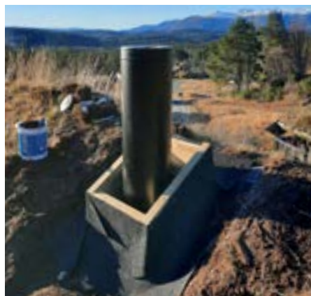
Innkassing kledd med takpapp/membran.
