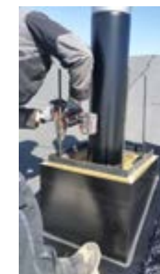
Montering av stålramme for armeringsjern
