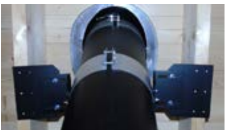
Montert justerbar loftstyring. Den justerbare loftstyringen leveres i to utførelser
