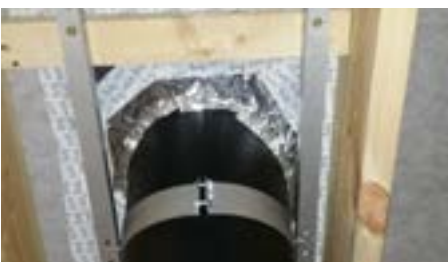
Eksempel på montert taksperrestyring. Taksperrestyring krever som regel montering av traverser mellom sperrene som vist på bildet
