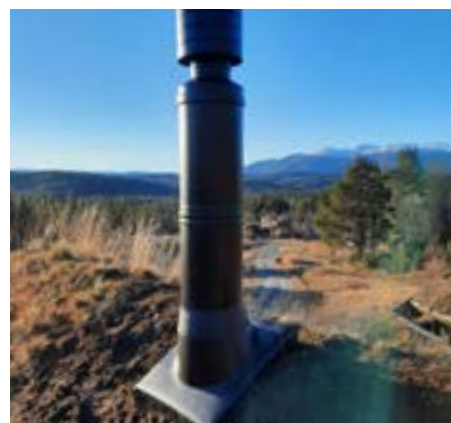
Ferdig installert med alu. takinndekning.
