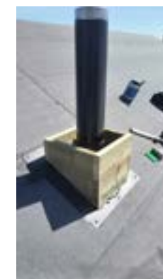
Innkassing med impregneret 2x4" konstruksjonsvirke
