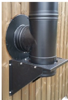
Vegggjennomføring og veggbrakett med bæreplate
