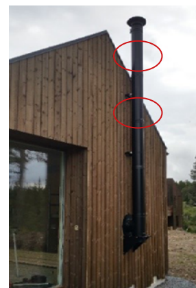
Komplett installasjon av A-pipe. Det må monteres veggfester 1 stk. pr. 3 meter.
