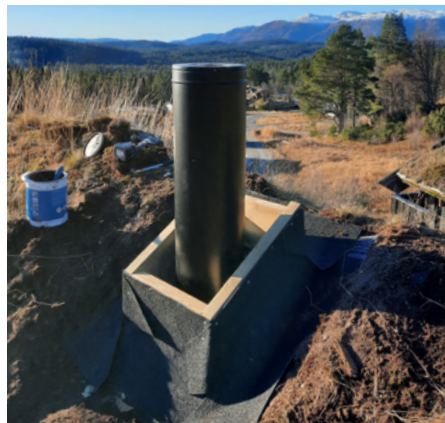
Innkassing kledd med takpapp/membran.
