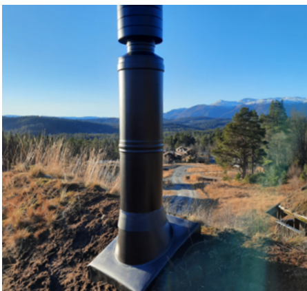
Ferdig installert med alu. takinndekning.
