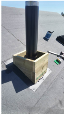
Innkassing med impregnert 2x4" konstruksjonsvirke
