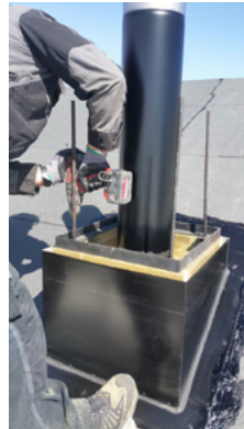
Montering av stållamme for armeringsjern
